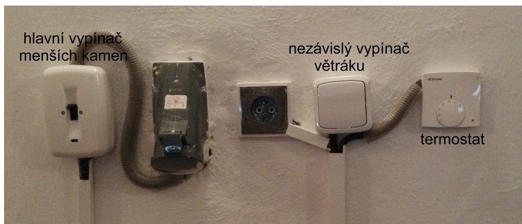
Obrázek 3: Ovládání malých kamen v řídicí místnosti na MUO.
